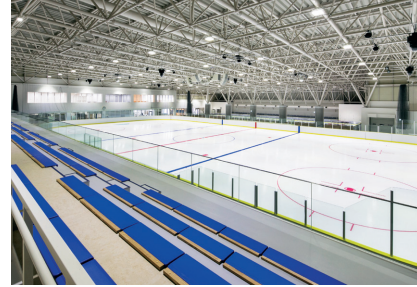
MGC三菱ガス化学 アイスアリーナ MGC MITSUBISHI GAS CHEMICAL Ice Arena フィギュアスケートやアイスホッケー等が楽しめる国際規格のメインリンクをはじめ、カーリングやスケート教室など幅広い用途に利用可能なサブリンクもあり、どなたでも氷上スポーツに親しんでいただける日本海側唯一の通年型氷上スポーツ施設です。
